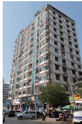
อาคารที่กำลังก่อสร้างอยู่ในตวันทาวน์
