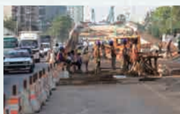
การก่อสร้างสะพานลอยที่แยก Hledan
